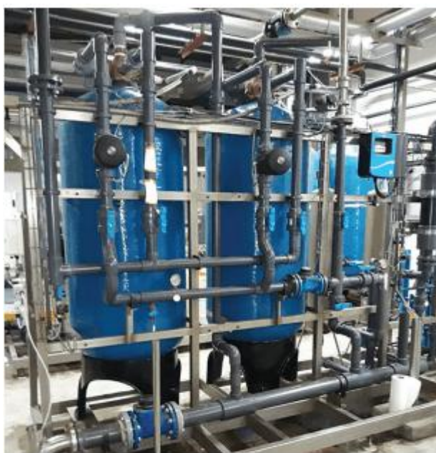
Sistema de filtração instalado em uma multinacional de produtos de higiene pessoal e cosméticos no Brasil que tem filtros duplos e abrandadores
